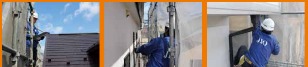
JIO検査員による完工検査
